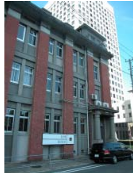
北仲BRICK 隣の復元した関東地方整備局の建物と連続している。
