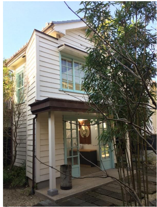
香取街道沿いの「いなえ」。街道沿いは商家 建築だが、中庭には洋風の建物がある。
