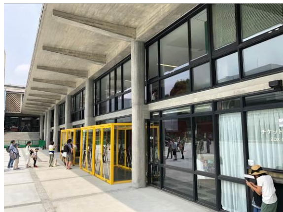
全面保存改修された神奈川県立音楽堂 (2019/0601 リニューアルオープン)
