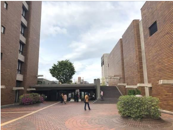
埼玉会館／前面道路からエントランスを見る
