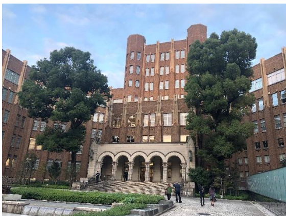
旧国立公衆衛生院を保存活用した港区郷土歴史館
