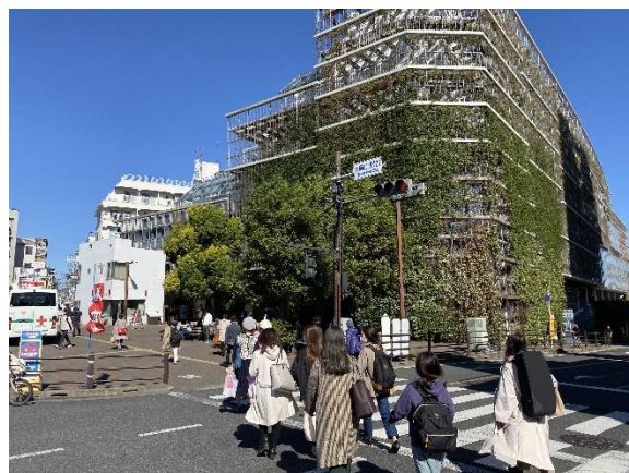
壁面緑化された大岡山駅ビル・東急病院
