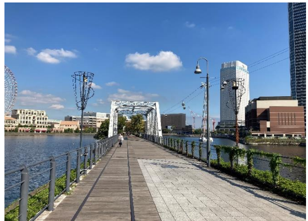
汽船道(桜木町駅側から赤レンガ倉庫方面を見る)
