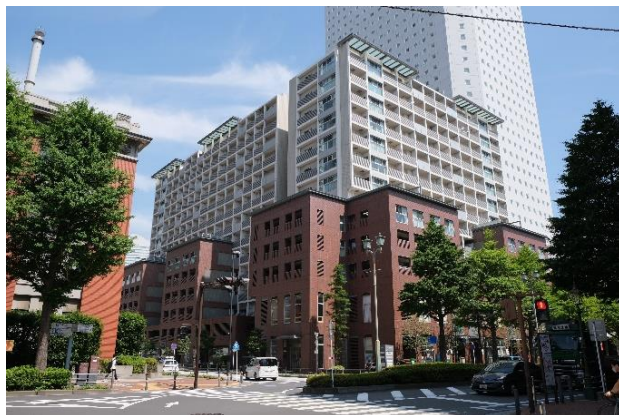
シャレール海岸通団地(UR 賃貸住宅 214 戸)
