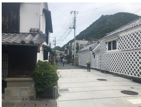
二棟の旧家を保存修景し、その間の道路を美舗装
