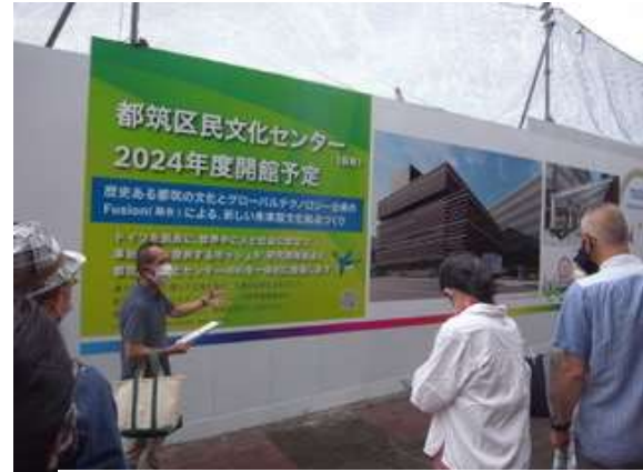
建設が進む区民文化センター
