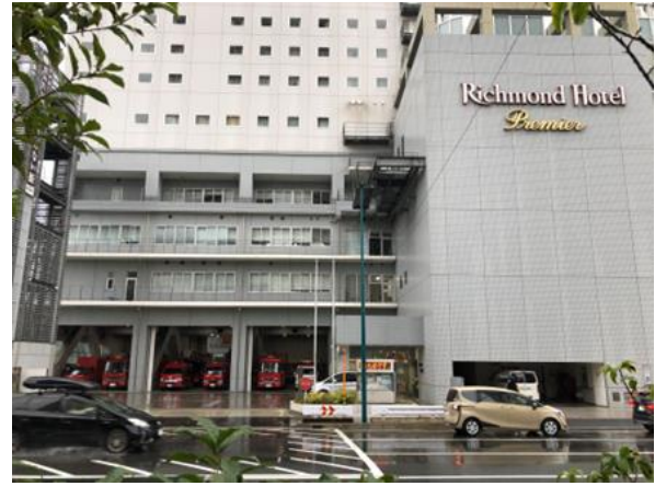
民間ホテルと立体的に複合した中原消防署
