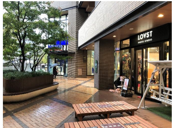
3丁目東再開発事地区の中庭広場と商業施設
