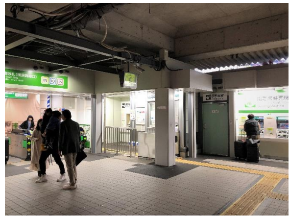
なお工事中の横須賀線・湘南新宿ライン新駅改札口
