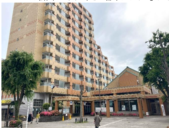
西国分寺駅南口／広場に面する都営住宅と小ホール
